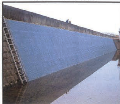
(護岸ブロック面防水)
