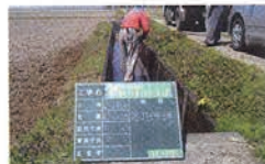
高圧洗浄工程
