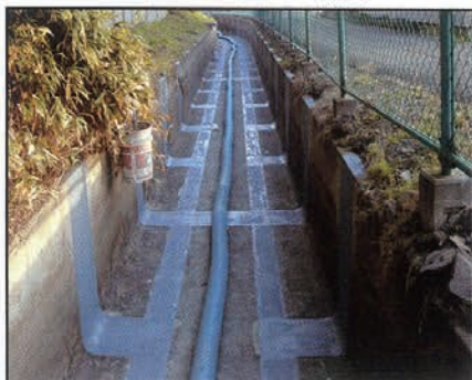
(L型水路目地補修)
