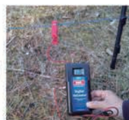
電圧点検風景
