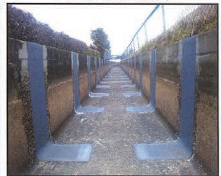
(L型水路目地補修)
