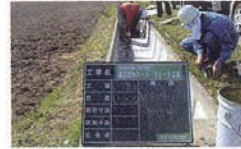
Vシート貼付
