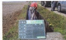
高圧洗浄工程
