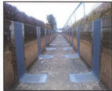
(L型水路目地補修)
