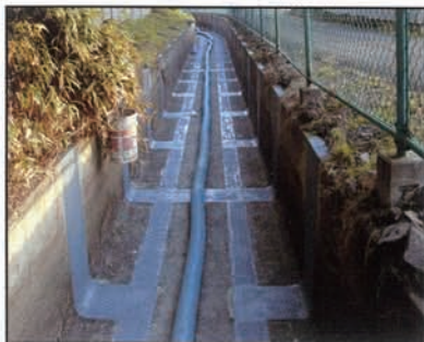
(L型水路目地補修)
