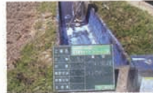
プライマー塗布
