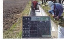
Vシート貼付
