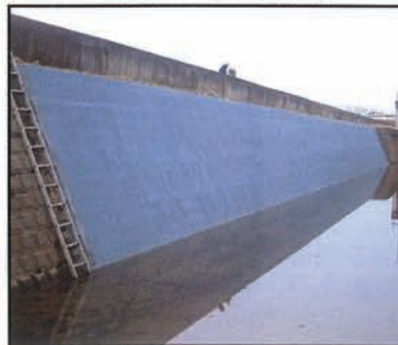
(護岸ブロック面防水)
