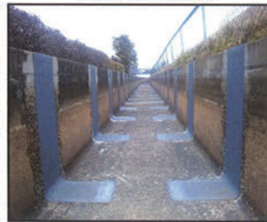
(L型水路目地補修)
