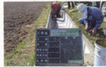
Vシート貼付
