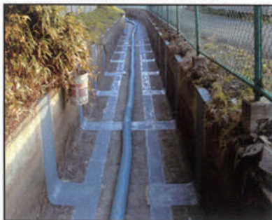
(L型水路目地補修)
